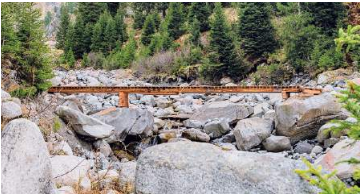
Eine neue Holzbrücke verbindet den Wanderweg über Puzzetta Sura.
