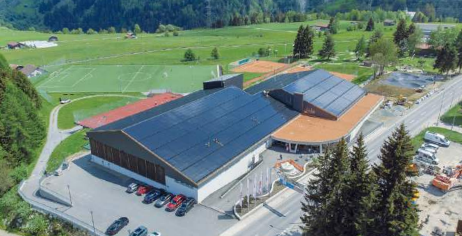
Das Center Fontauna wurde in den letzten Jahren renoviert und ergänzt.
