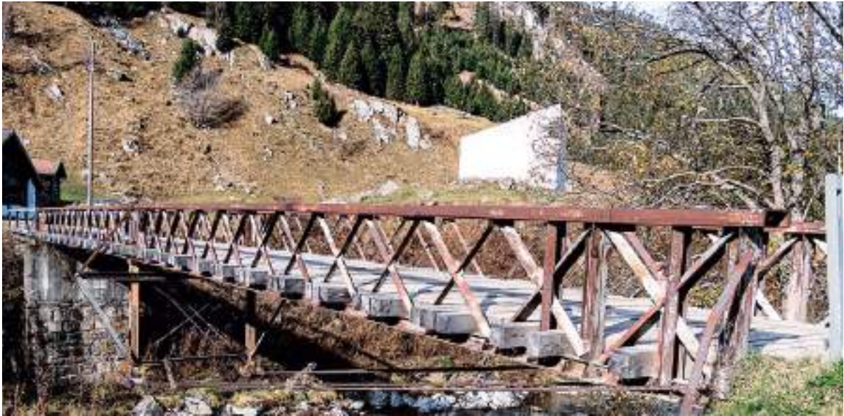
Die Eisenbrücke verbindet Acla mit der Kantonsstrasse.
