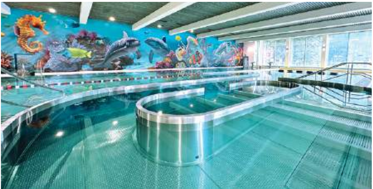
Das alte Schwimmbecken wurde vollständig saniert und durch ein modernes Chromstahlbecken ersetzt.
