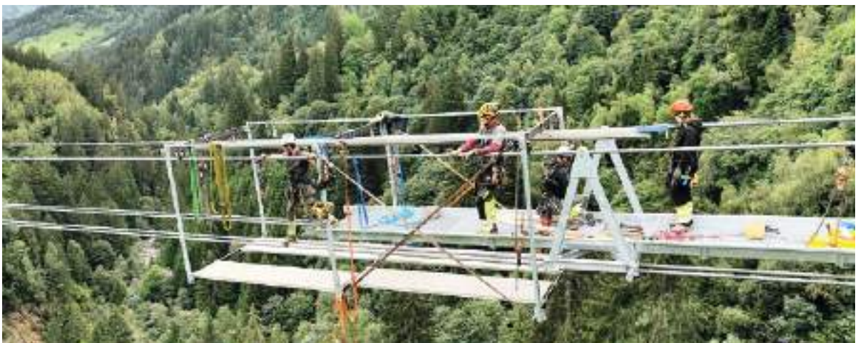
Die längste Hängebrücke Graubündens während den Bauarbeiten. Foto Christian Loretz
