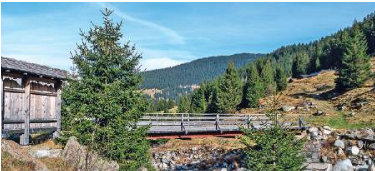
Die Brücke in Pardatsch in der Val Plattas. Fotos Claudio Simonet und Gemeinde Medel/Lucmagn
